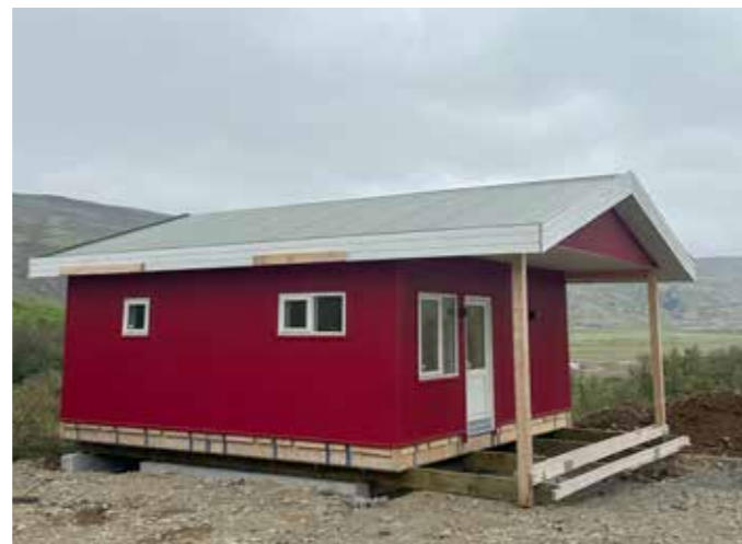
Fellið, nýtt 45 fm starfsmannahús var keypt tilbúið og flutt í heilu lagi í Vindáshlíð 18. ágúst 2025. Húsið stendur á grunni gömlu Fellana, starfsmannahúsa sem voru rifin fyrir nokkrum árum.
