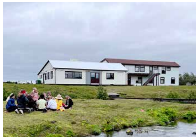
Í ástandsmati sem verkfræðistofan Ferill gerði fyrir stjórn Kaldársels haustið 2024 kemur fram að vinna við lagfæringar á öllum þeim atriðum sem krefjast úrbóta í eldri hluta skálans er kostnaðarsamari og tímafrekari en algjör niðurrif og enduruppbygging. M.ö.o. endurbyggja þarf elsta hlutann frá grunni. Eldri hlutinn er vinstra megin á myndinni.
