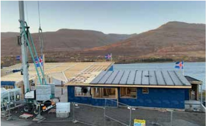
Risgjöld nýja matskála voru 4. október 2024.
