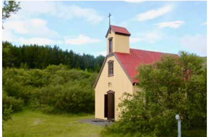
Hallgrímskirkja í Vindáshlíð. Ný vindskeið var sett á kirkjuskipið við kórinn og settur voru upp nýjir olíufylltir rafmagnsofnar.
