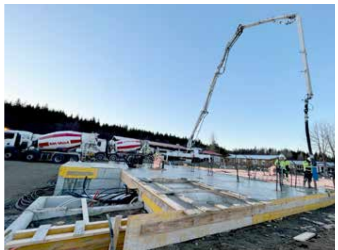
Framkvæmdir við grunn hins nýja matskála hófust í júlí og gólfplatan steypd 9. nóvember.
