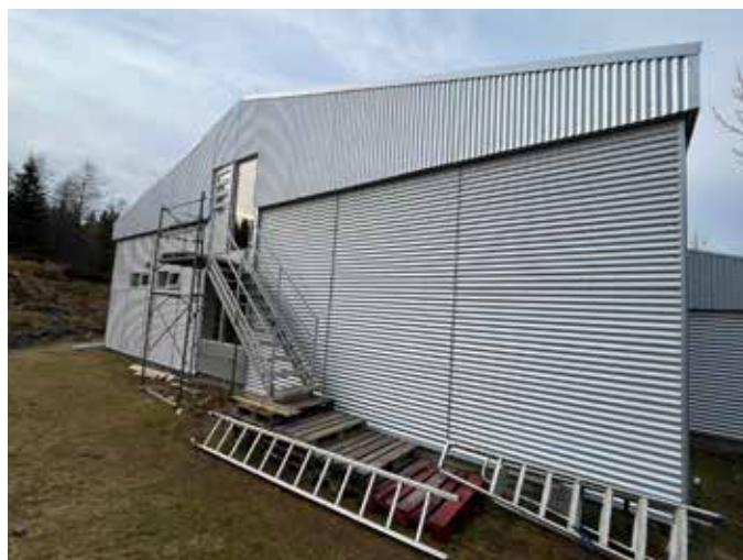
Unnið var að endurnýjun á austurhlið íþróttahússins síðastliðið sumar og fram á haust. Verkið tókst vel til og nú er beðið eftir nýjum brunastiga.
