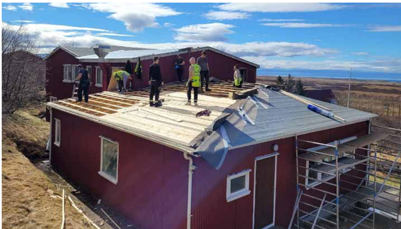
Farið var í framkvæmdir á þaki aðalskálans sumarið 2022, var það Trésmiðja Þráins sem sá um verkið.
