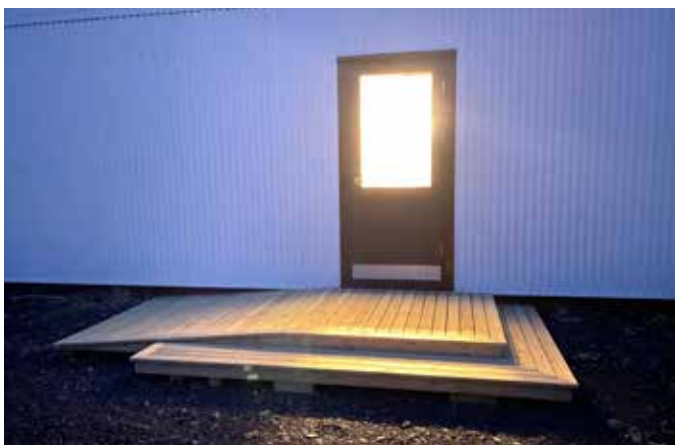
Pallur og rampur var settur upp við nýja hurð á austurgafli skálans.
