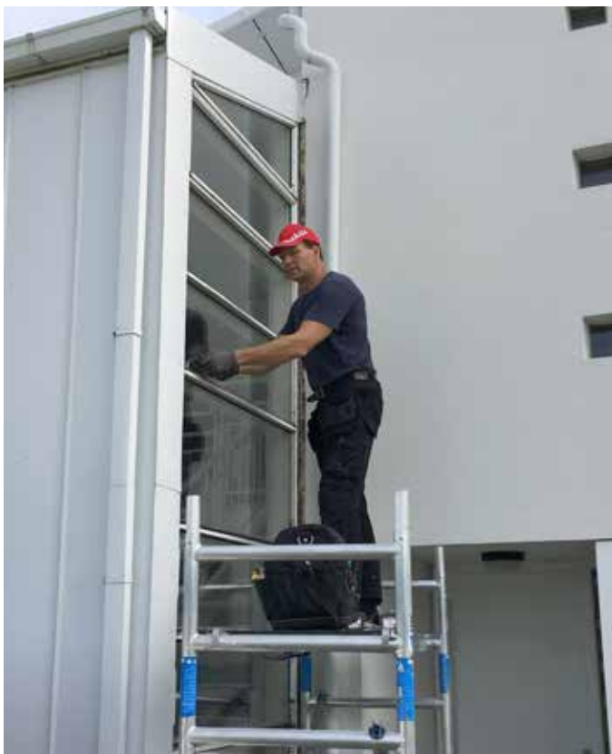
Gluggarnir á aðalstöðvum félagsins voru víða illa farnir. Á starfsárinu voru þeir lagaðir og endurnýjaðir eftir þörfum. Á myndinni má sjá Björn Þór Baldursson smið að störfum.
