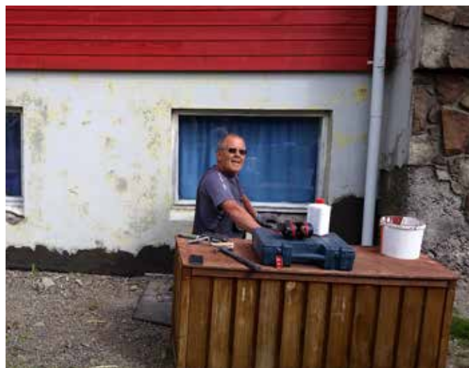
Helstu framkvæmdir á starfsárinu voru að nýbyggingin var máluð að utan og var verkstjórn og vinna að langmestu leiti í höndum Guðmundar Ómars Guðmundssonar en hann gaf jafnframt alla málningu til verksins.
