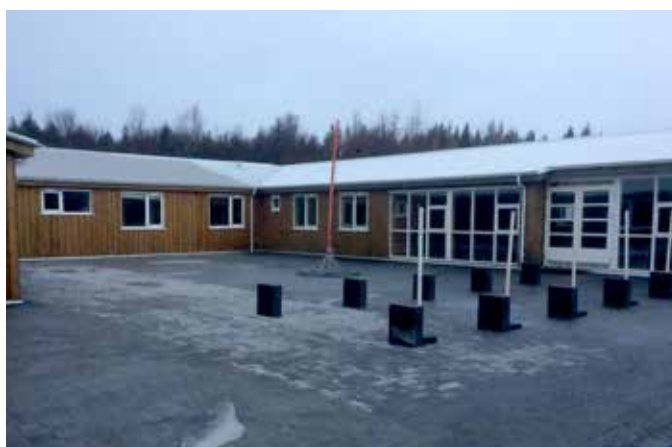
Í framhaldi af malbikunarframkvæmdum var portið við Birkiskála hellulegt upp á nýtt.
