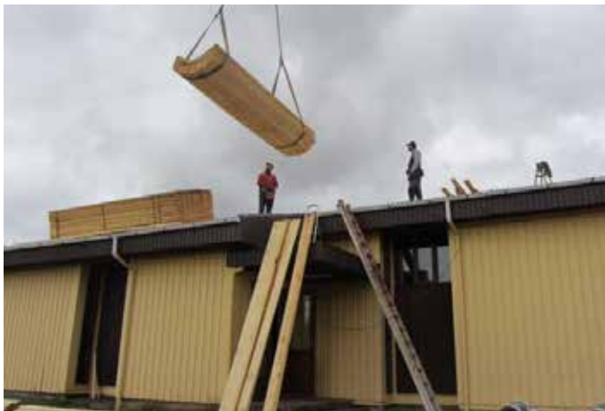
Pann 9. september hófust framkvæmdir á þaki íþróttahússins og var skipt um járn, klæðningu og þakpappa. Willy Petersen hafði yfirumsjón með verkinu
