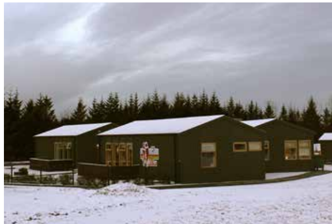
Vinagarður er staðsettur á lóð félagsins við Holtaveg í Reykjavík.
